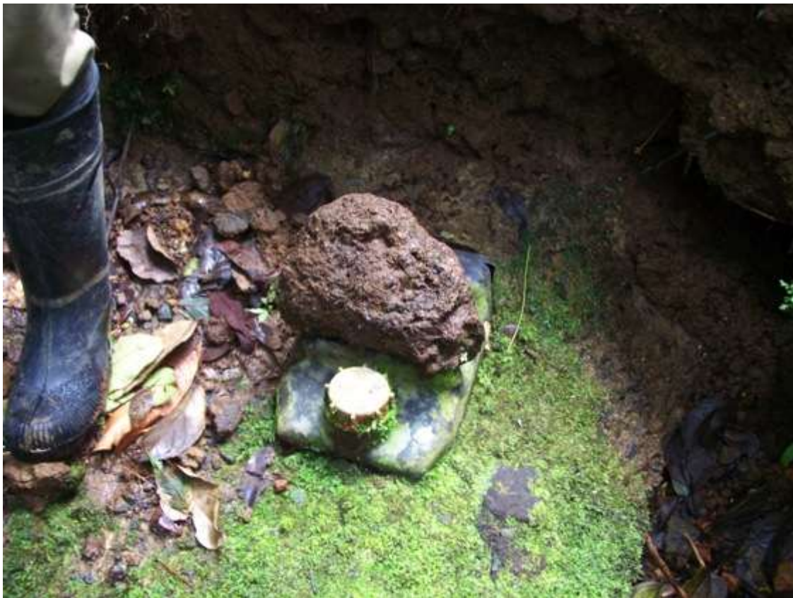
Foto 5. Toma de agua de la Naciente 3 de la Llorona (Mala)
