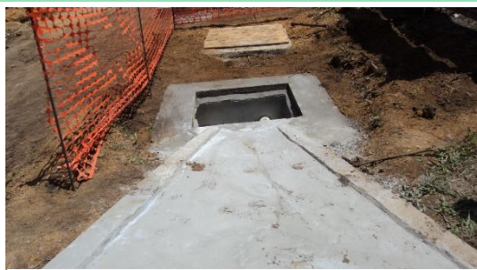
Inspecciones de obra: sedimentador CeU de Pérez Zeledón.
