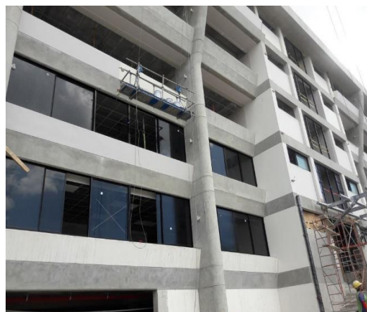
Obra constructiva: Iniciativa 8 Edificio Ii+D
