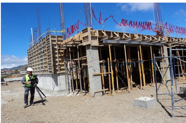
Obra constructiva Iniciativa: 2 CeU Cartago
